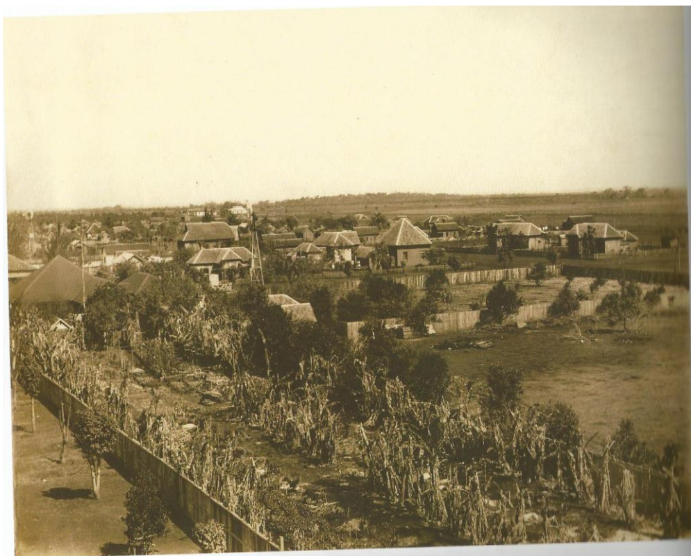
Fig. 21. Fazenda Campanário, moradia dos funcionários. ( apud MAGALHÃES, 2013, p. 170)
