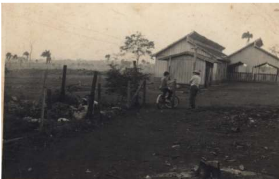
Figura 17: Vista parcial da construção da Escola Reunida São Pedro, 1957.
