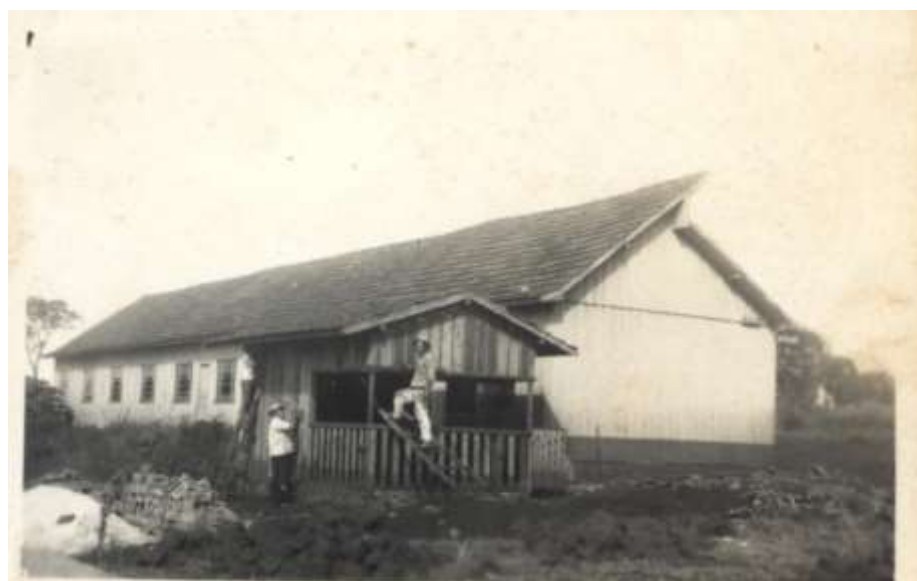
Figura 19: Construção da Cantina Escolar (1968)
