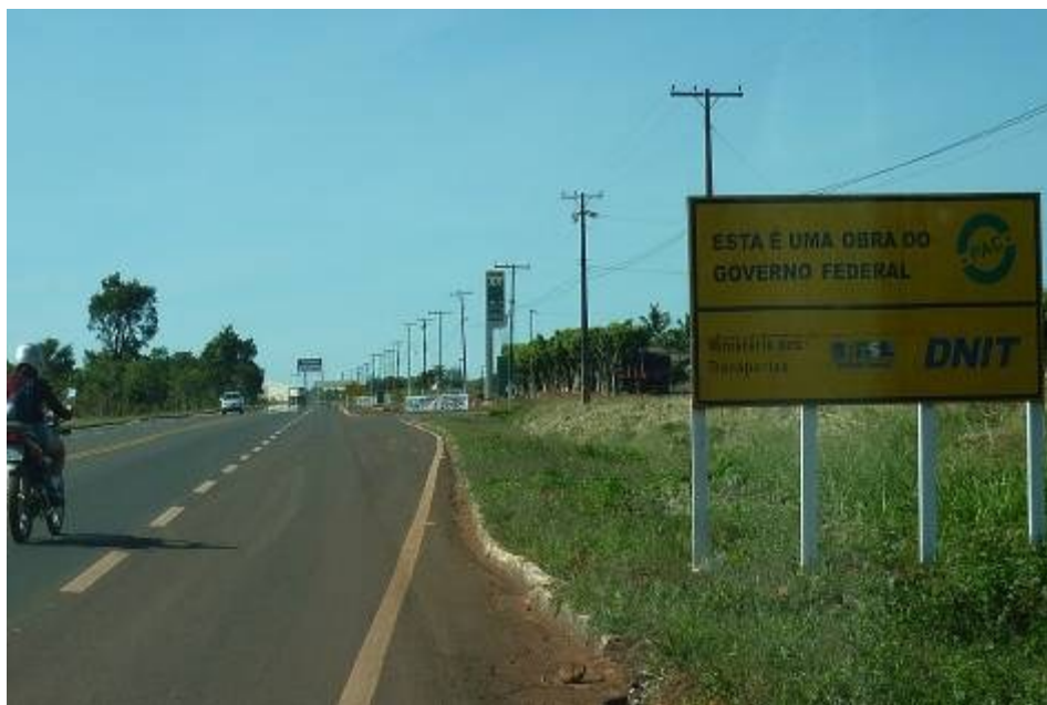
Foto 10 – Trecho contemplado com obras do PAC na BR-163 em Campo Grande
