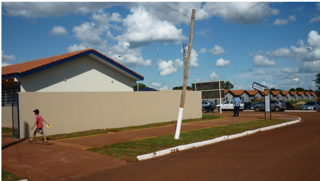
Foto 9 – No primeiro plano a Escola Municipal Luiz Antonio e no segundo plano as casas em construção no Conjunto estrela Tovy em fevereiro/2010
