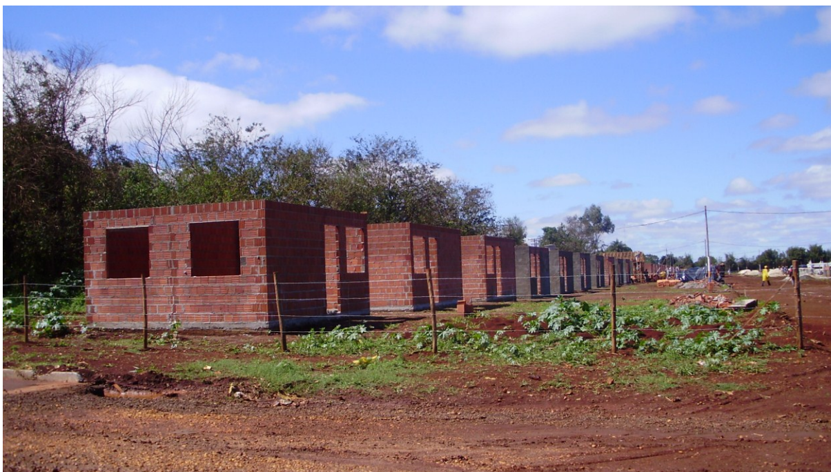
Foto 6 – Casas em construção no Conjunto Estrela Tovy em agosto/2009
