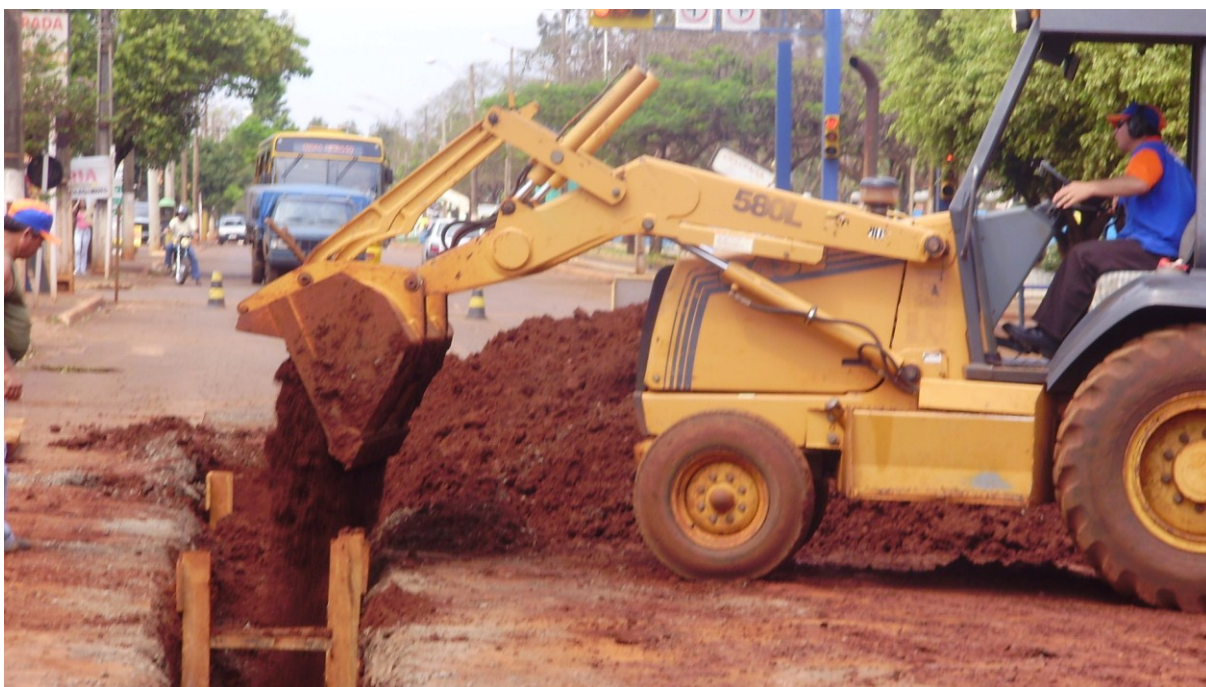
Foto 21 – Obras de implantação da rede coletora de esgoto na Vila Industrial
