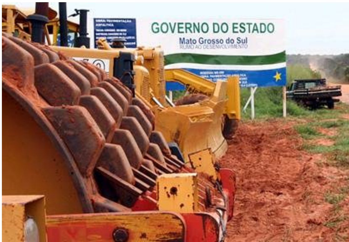
Foto 12 – Aspecto da MS-040 no início das obras de pavimentação
