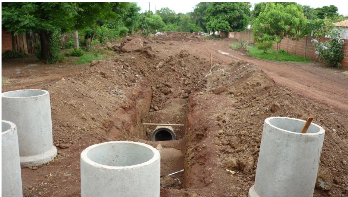
Foto 11 – Execução das obras de drenagem na Vila Cachoeirinha em dezembro/2009
