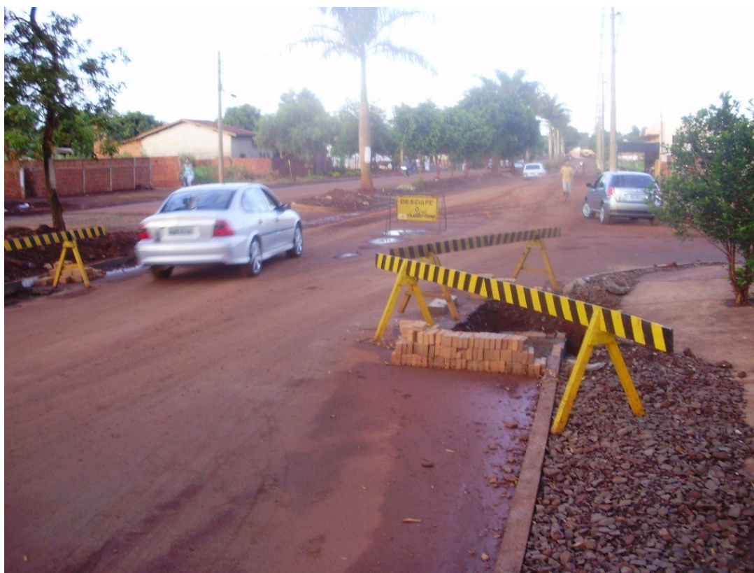
Foto 12 – Execução das obras de drenagem na no Parque do Lago em novembro/2008
