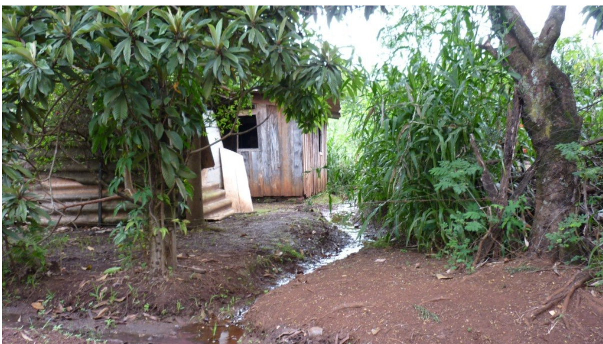
Foto 4 – Moradia construída em área de risco às margens de uma vala de escoamento de água na “Favela do Clímax”
