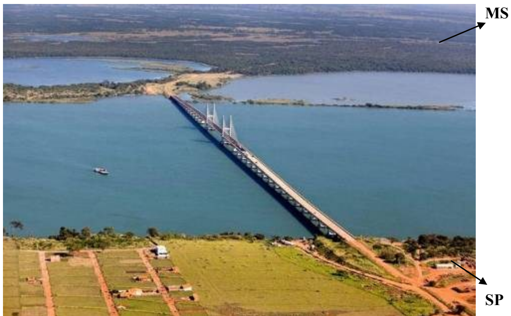
Foto 13 – Vista área da ponte Mário Covas sobre o Rio Paraná
