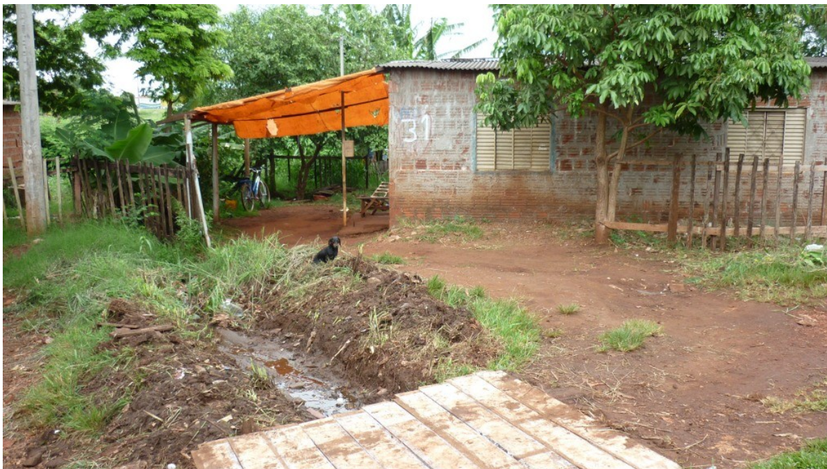
Foto 3 – Esgoto à céu aberto na “Favela do Clímax” em 2010
