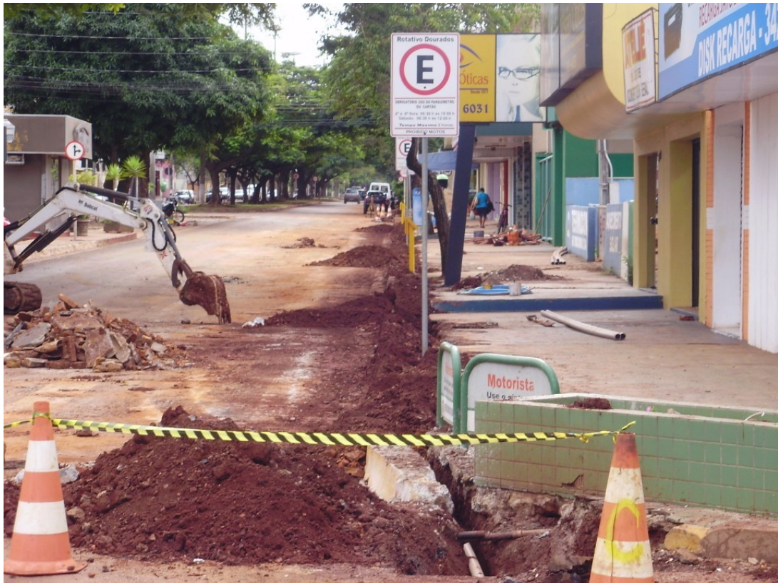
Foto 15 – Execução das obras no sistema de abastecimento de água junho/2009
