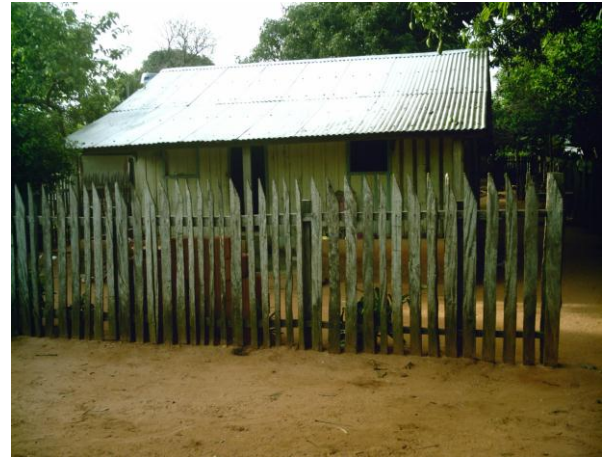
FOTO 15: Casa de Morador da Colônia Fonte: Trabalho de Campo (2011)
