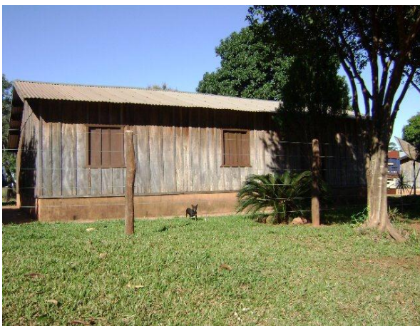
FOTO 16: Casa de Morador da Colônia Fonte: Trabalho de Campo (2011)
