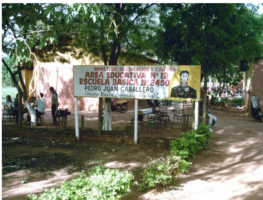
FOTO 32: Faixada Externa da Escola "Pedro Juan Caballero" Fonte: Trabalho de Campo (2011)
