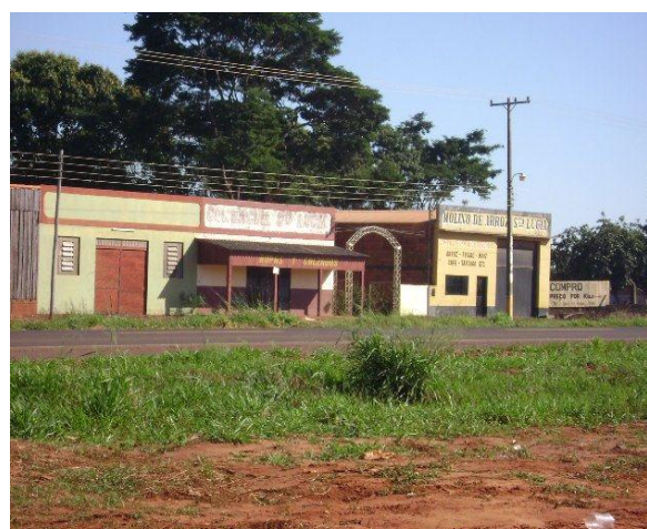
FOTO 46: Armazéns e Empacotadora Fonte: Trabalho de Campo (2011)
