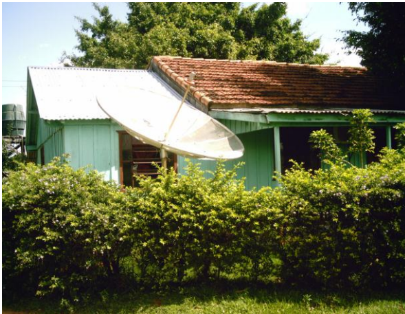
FOTO 14: Casa de Morador da Colônia Fonte: Trabalho de Campo (2011)
