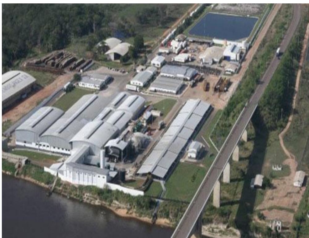
FOTO 22: Estrutura do Frigorífico Concepción
