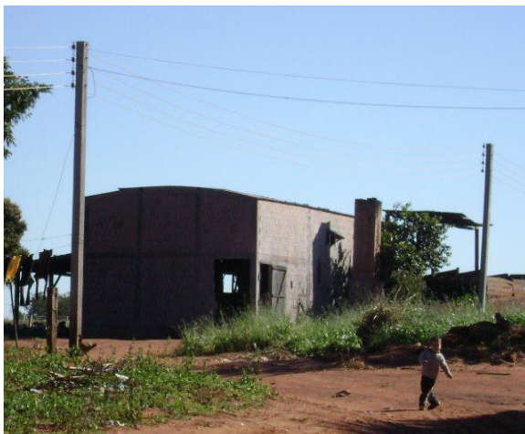
FOTO 28: Estrutura Externa da Farinheira Fonte: Trabalho de Campo (2011)
