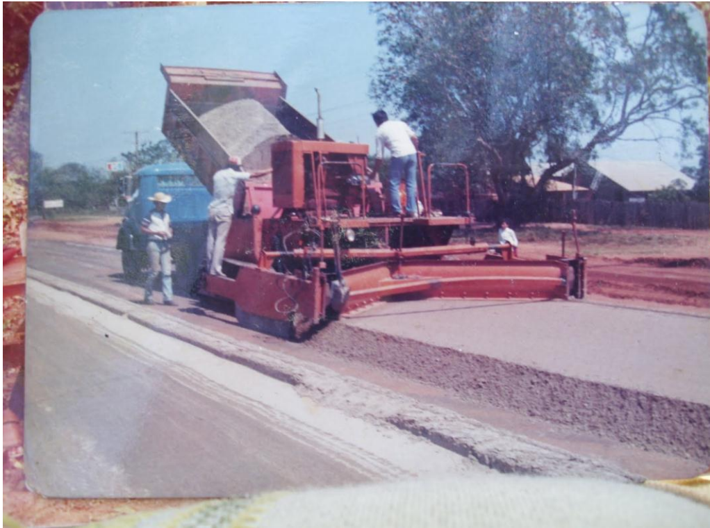
FOTO 21: Foto do Retrato da Pavimentação Ruta 5 Fonte: Trabalho de Campo (2011)
