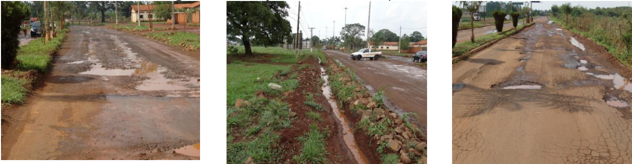
Figura 4- Condições do local a ser pavimentado
