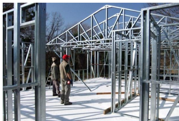
Figura 4: Perfis utilizados para painéis e tesouras de cobertura.
