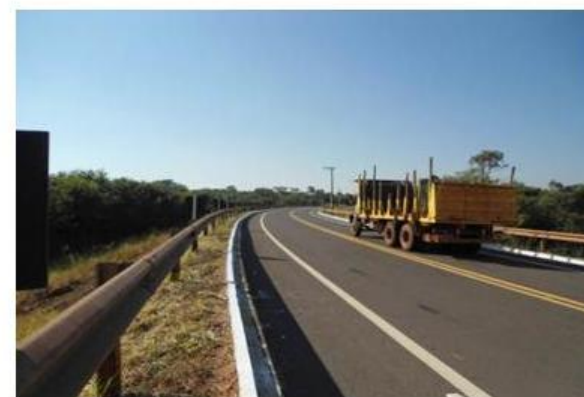
MS-040 depois da colocação da cobertura asfáltica em seu trecho final. Fonte: Katia Kyahara da Silva, 2008.
