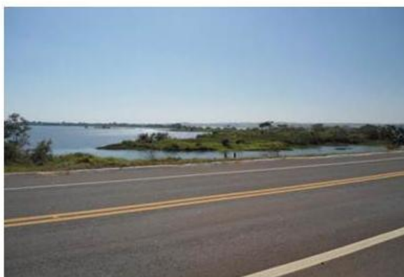
MS-040 depois da colocação da cobertura asfáltica em seu trecho final. Fonte: Katia Kyahara da Silva, 2008.
