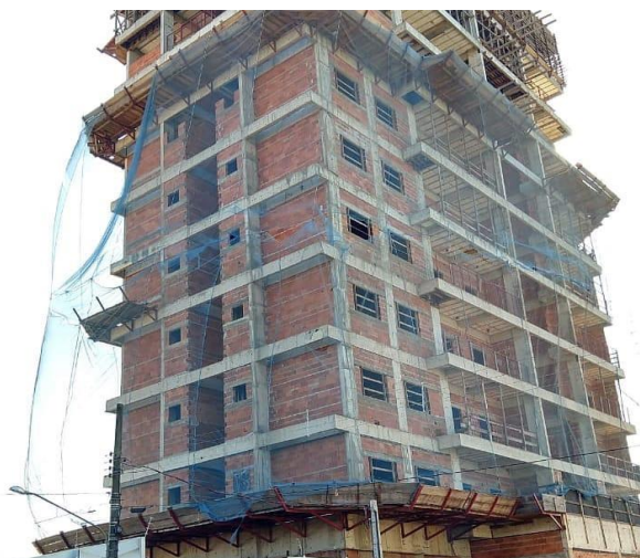
Figura 18. Utilização da rede de proteção na empresa A.
