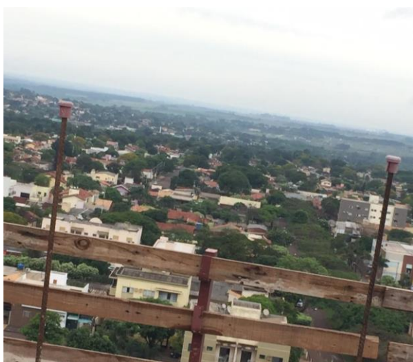
Figura 12. Proteção nas pontas dos vergalhões da empresa A.
