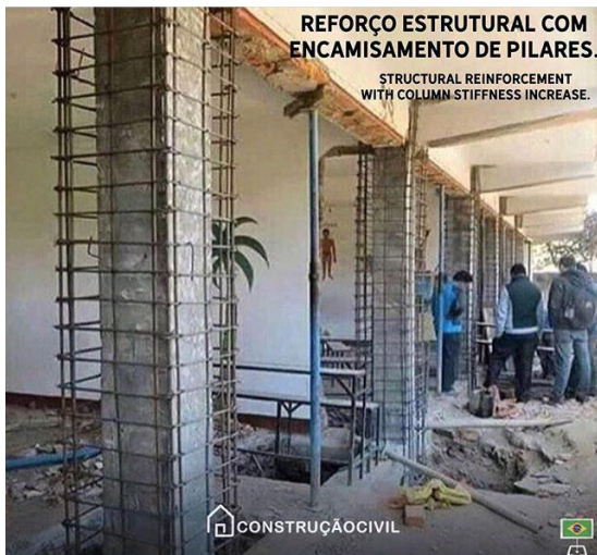
Figura 2. Reforço de pilar por encamisamento com concreto armado.
