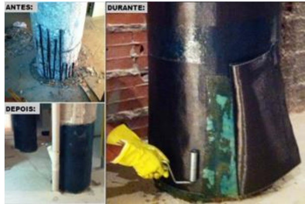
Figura 4. Reforço de pilar por confinamento de fibras de carbono.
