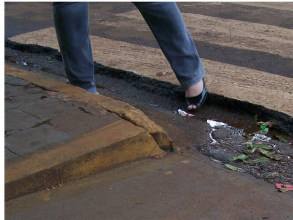
**Figura 77 - Deformação no asfalto próximo à rampa – Área central da cidade. (NASCIMENTO, 2009)**
