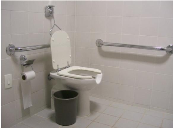
**Figura 74 – Bacia sanitária com barras de apoio lateral e de fundo – Estabelecimento Bancário (NASCIMENTO, 2009)**
