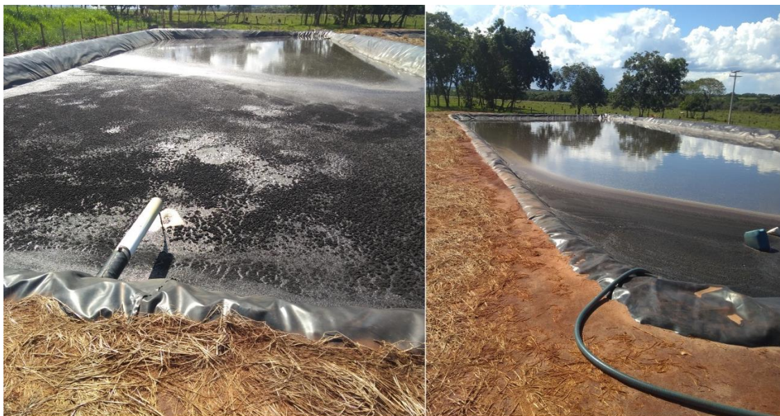
Figura 25: Lagoas de decantação que servem como reservatório do Biofertilizante
