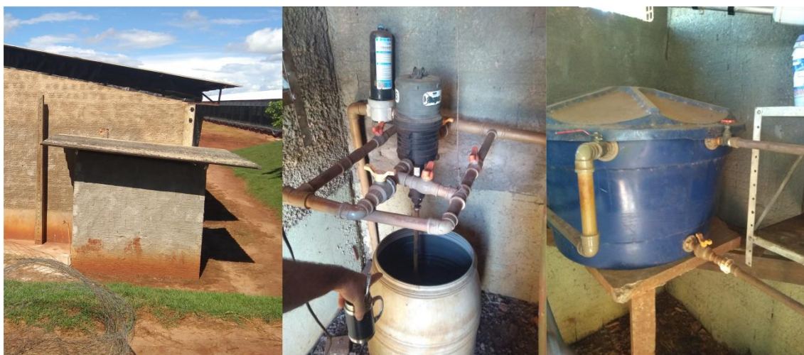
Figura 18: Estação de tratamento localizada na extremidade do galpão
