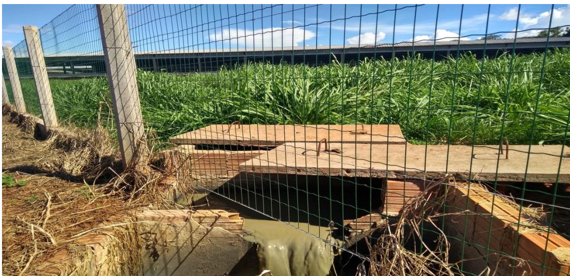
Figura 23: Entrada dos Efluentes na área do Biodigestor, com visão do galpão ao fundo
