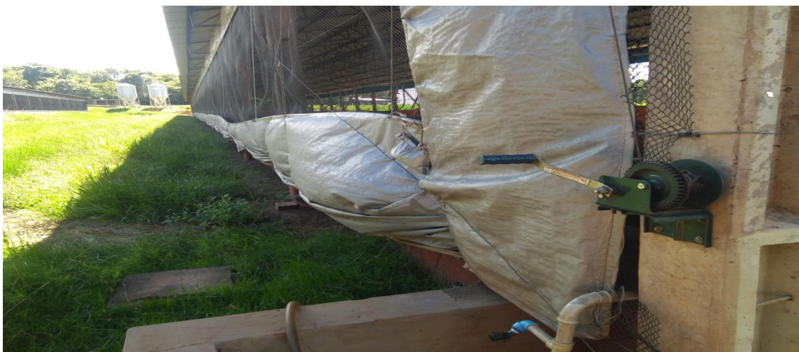
Figura 22: Cortina de controle de temperatura abaixada
