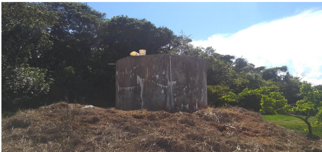
Figura 17: Caixa D'água que armazena e distribui para a propriedade
