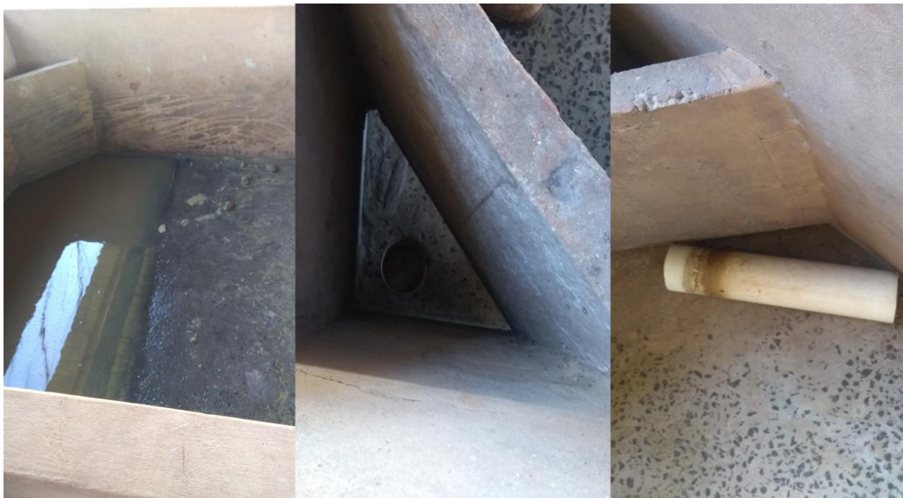
Figura 14: Sistema de lâmina d'água e sistema de fechamento do ralo
