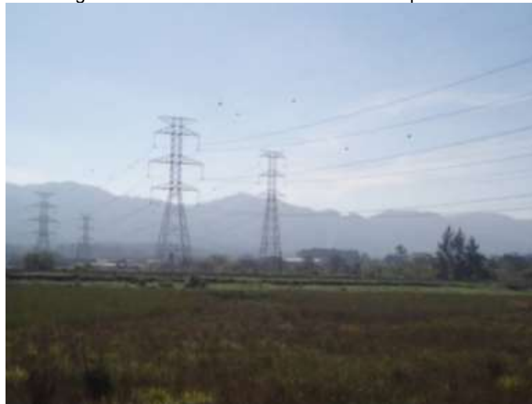
Figura 1-1: Linhas de Transmissão de alta potência.
