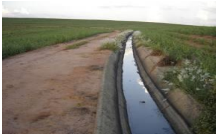
Figura 2.5 – Ilustração que representa o canal de distribuição de vinhaça
