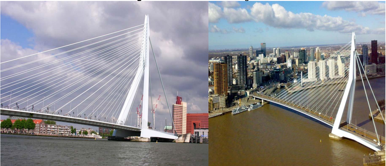
Figura 2- Ponte Erasmus Bridge.
