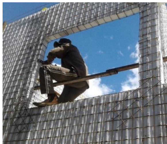
Figura 5- Reforço do tipo Liso para cantos de aberturas
