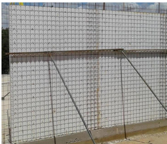
Figura 6- Equipamentos de auxílio para montagem
