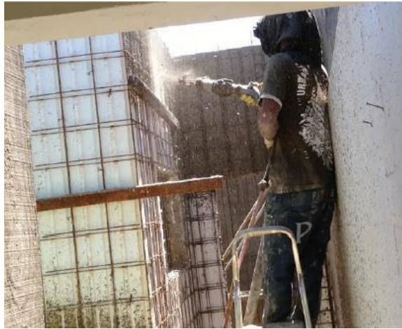
Figura 8- Projeção de argamassa
