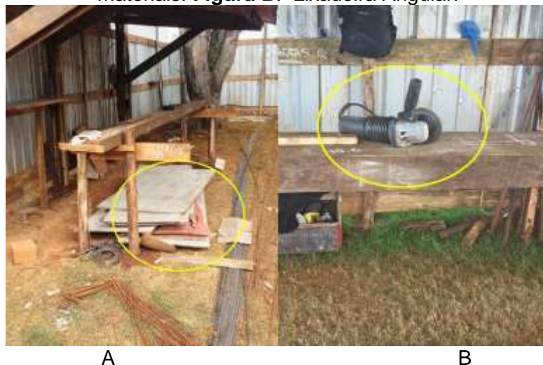
Figura 5-A: obstrução da circulação na bancada de carpintaria pelo depósito incorreto de materiais. Figura B: Lixadeira Angular.
