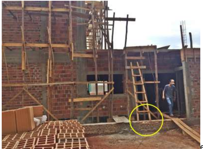
Figura 7 - Escada de mão posicionada sobre o muro de arrimo.
