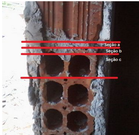
Figura 06-Seções da alvenaria
