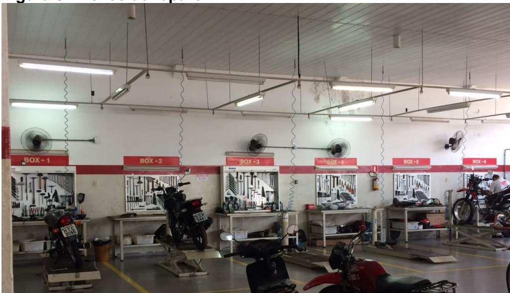
Figura 6 - Boxes de reparo
