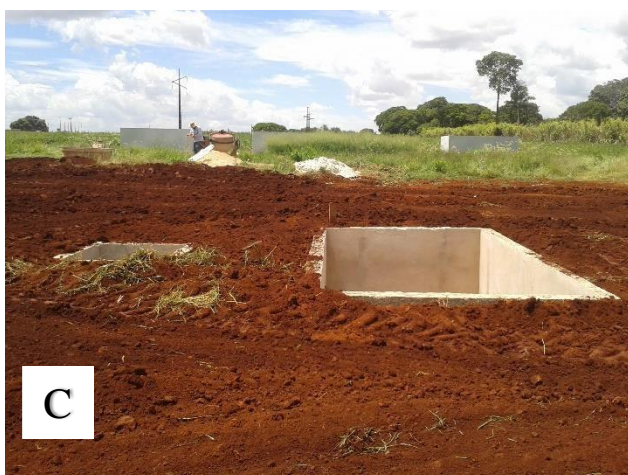
FIGURA 7. Instalação do lisímetro. (A) Vista de cima do interior do lisímetro, (B) Tanque que será apoiado nos pilares e (C) Lisímetro instalados ao nível do solo.
