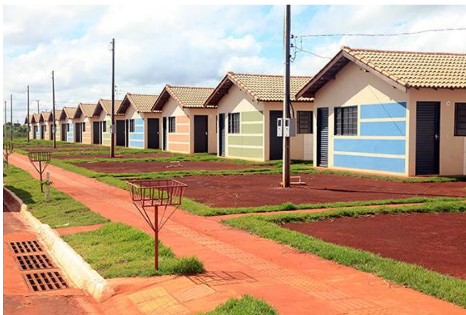
Figura 10 – Conjunto Habitacional Harrison de Figueiredo II.
