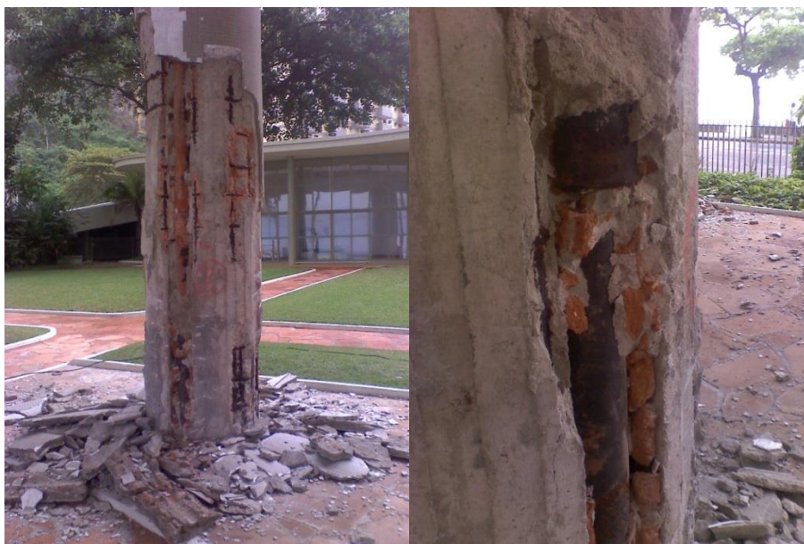
Figura 2 Foto de pilares comprometidos estruturalmente, metal corroído no interior do concreto resultando na quebra do concreto
