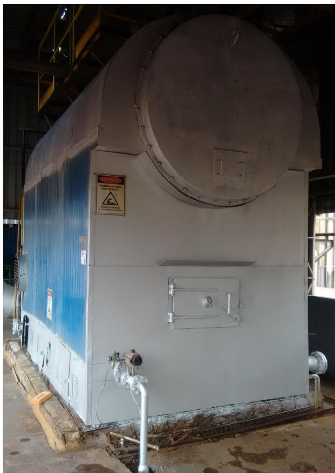
Figura 19 – Caldeira Flamotubular ATA 25LC (Fonte: Elaborada pelo autor, 2016).
