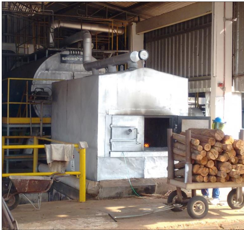
Figura 18 – Caldeira Flamotubular Sermatec MZL 10.2 (Fonte: Elaborada pelo autor, 2016).
