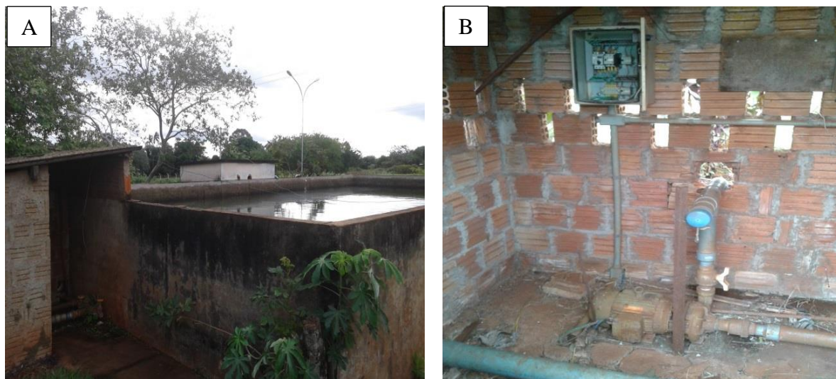
Figura 7. Captação e recalque de água para irrigar o experimento: reservatório (A) e conjunto moto-bomba (B).
