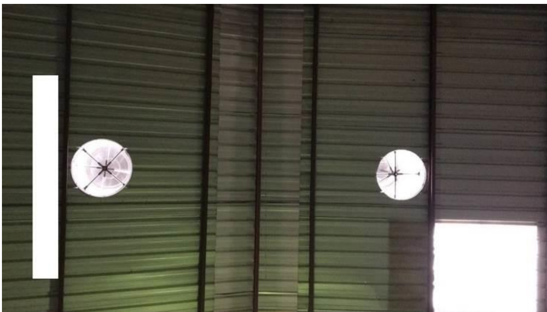
Figura 7: Exaustor eólico na fábrica. Fonte: Foto tirada na empresa.
