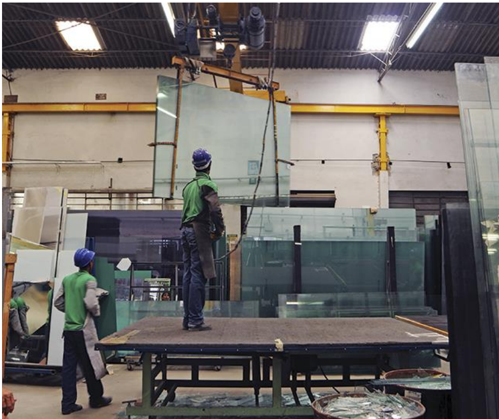
Figura 1: Cinta de aço em ponte e empilhamento. Fonte: (PONTES,2016).
