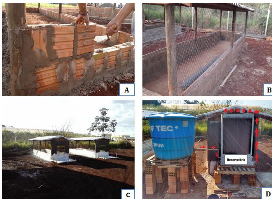
Figura 2: A: processo de construção das muretas; B: fixação das telas; C: pintura dos aviários; D: sistemas de climatização – aviário 2.
