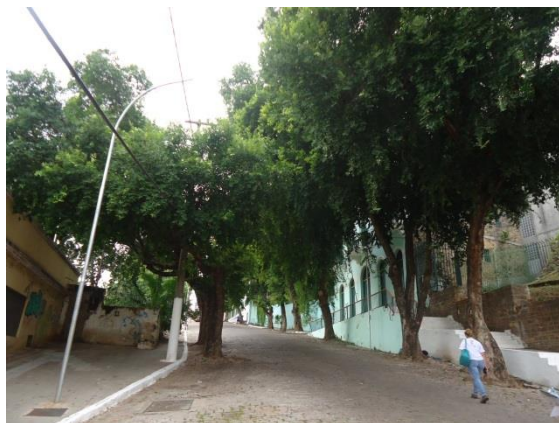
Figura 39: Copa da árvore em conflito com rede elétrica e telefônica. Fonte: Oficinas de Cidadania Participativa. Data: maio/2014.
