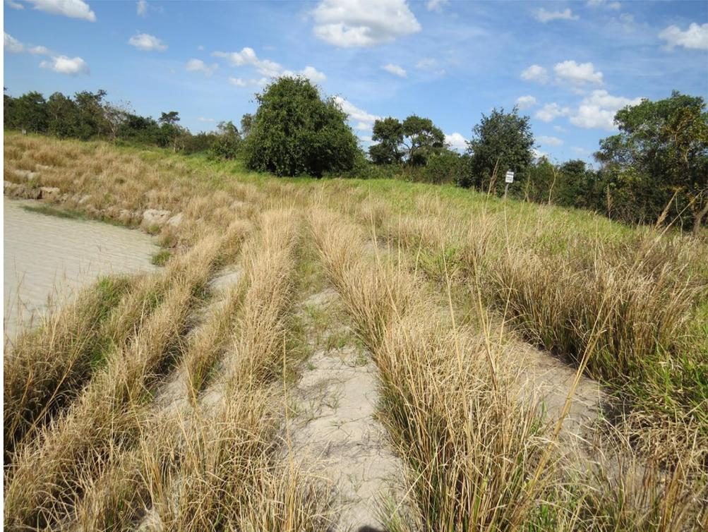
Figura 09 – Visão geral de parte do talude recuperado dezoito meses após a implantação do capim vetiver (Dourados).
