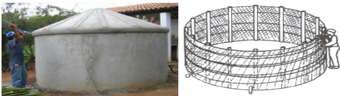
Figura 5: Representação de cisterna do tipo ferro cimento.
