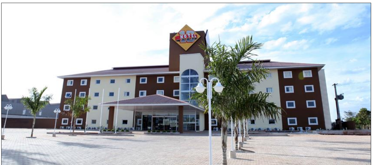
Figura 12: Fachada do Hotel 10/Dourados
