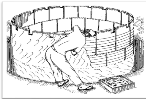
Figura 3: Construção de cisterna com placas de cimento Fonte: GNADLINGER (2000).
