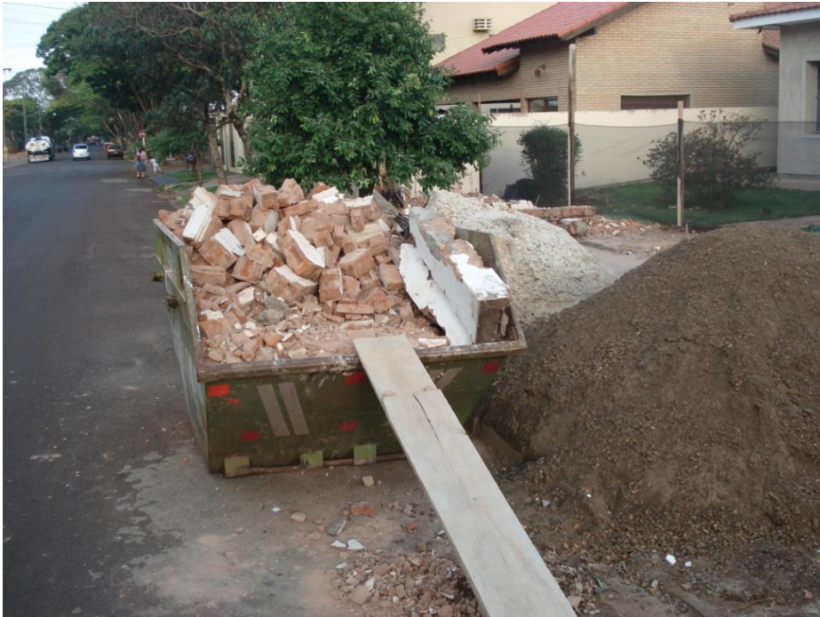
Resíduos em obras4: Rua Ciro Melo.
