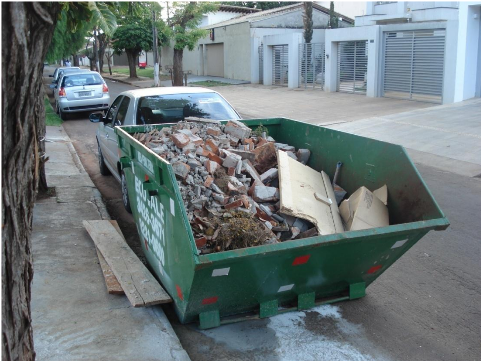
Resíduos em obras2: Rua Fernando Costa da Lima.
