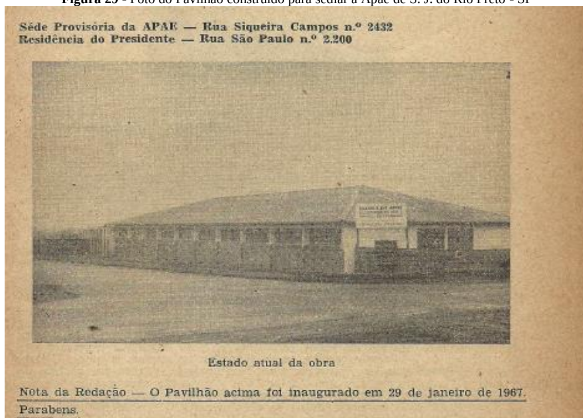
Figura 29 - Foto do Pavilhão construído para sediar a Apae de S. J. do Rio Preto - SP
