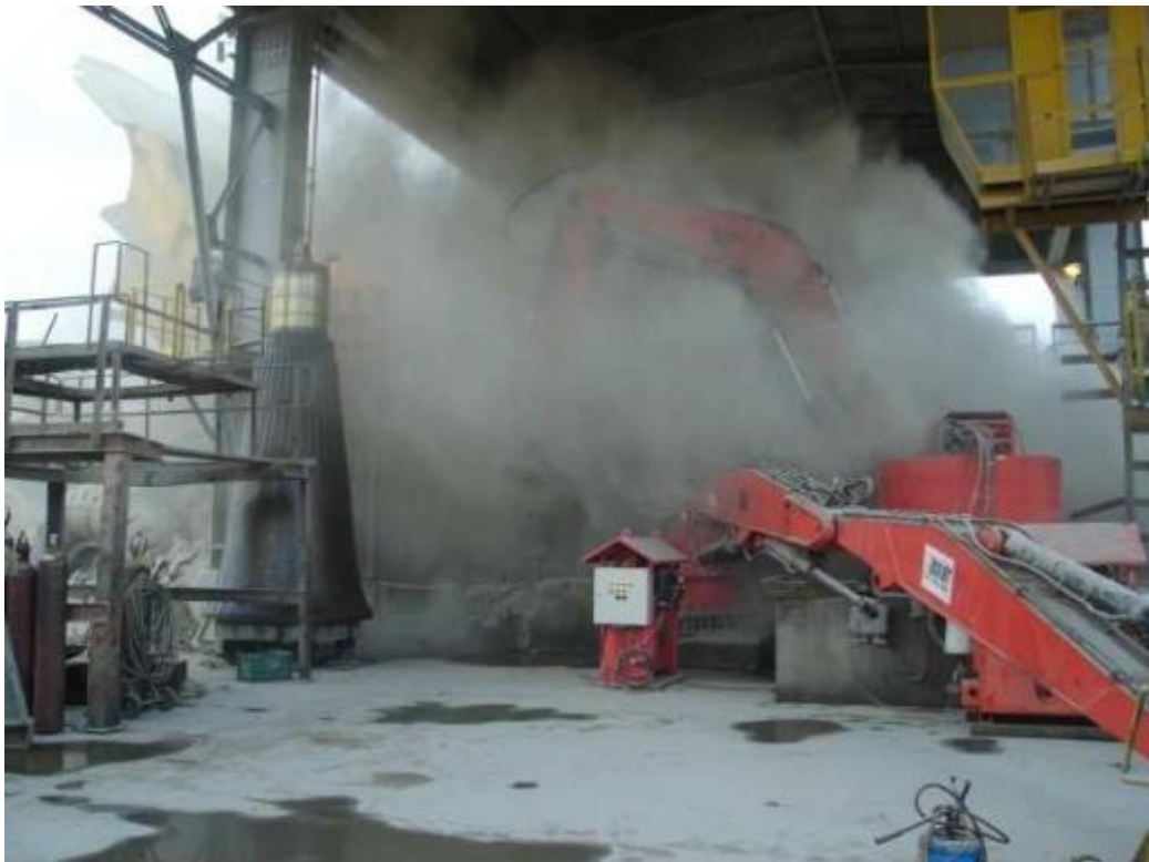
Figura 3 - Descarga de material no britador primário
