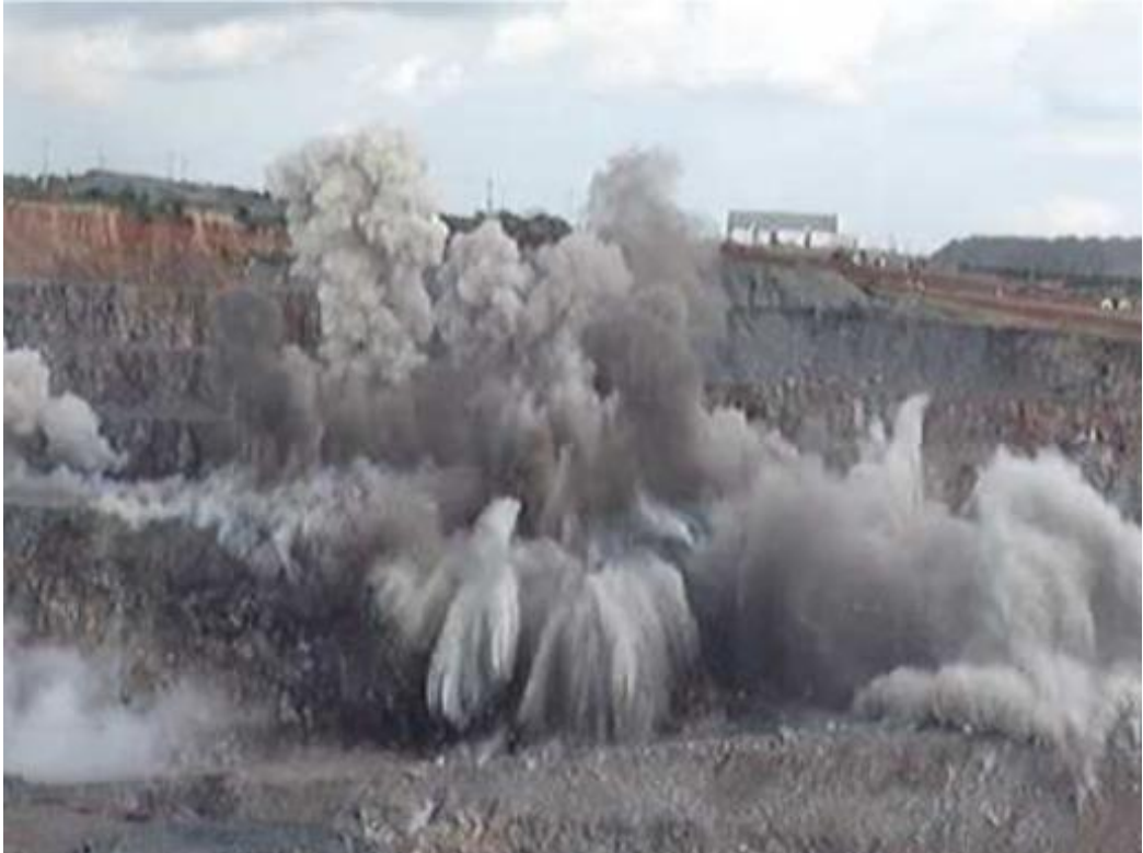
Figura 2 – Desmonte de rocha
