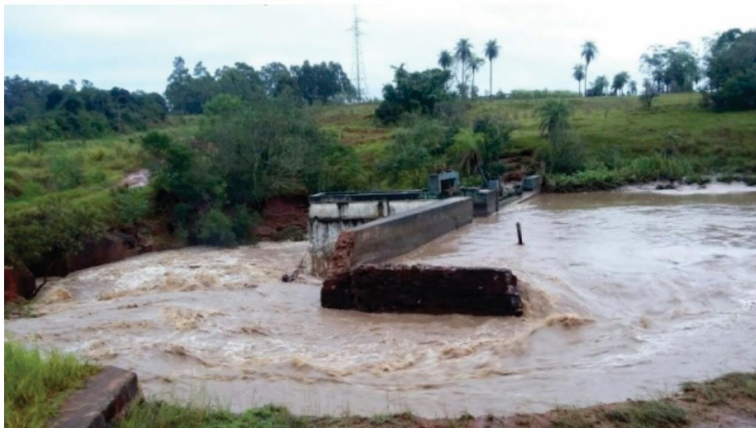
Barragem do rio Piraí, em Iguatemi rompeu na tarde de ontem (9) devido as chuvas constantes dos últimos dias. (Foto: Divulgação)
