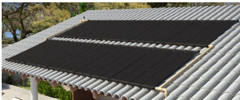
Figura 3 – Coletores solares em paralelo.
