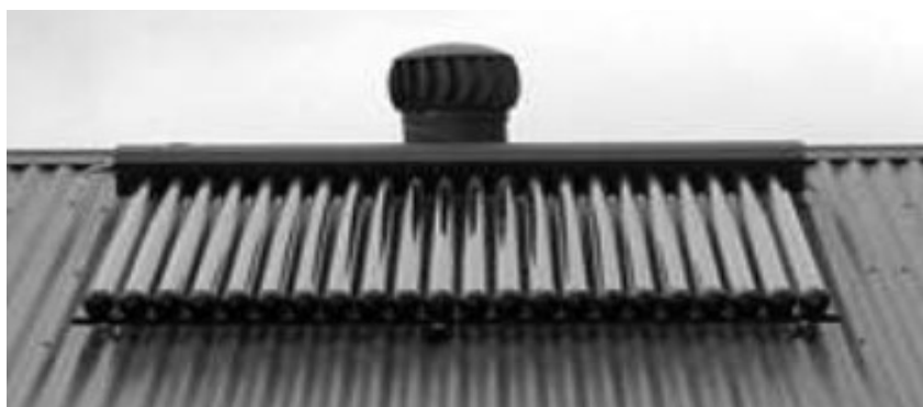
Figura 10 – Coletor Solar de Vácuo.
