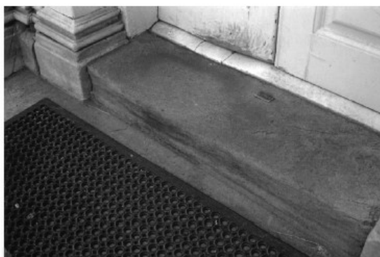
Figura 6 – Exemplo de desgaste abrasivo através dos anos
