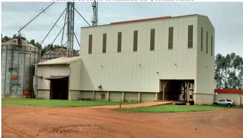
Foto 29 – Município de Terenos Fábrica de ração localizada na Colônia Jamic
