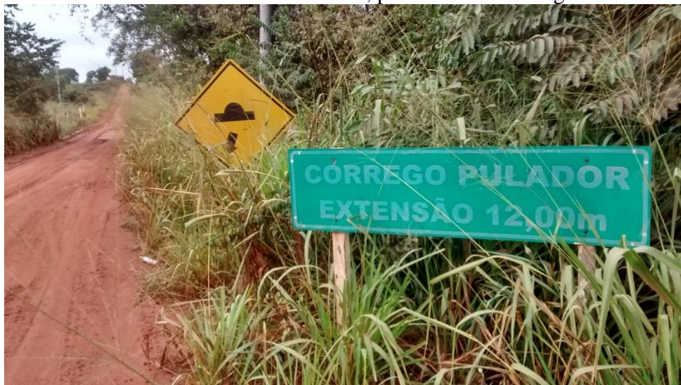
Foto 2 – Município de Anastácio Estrada de acesso à Colônia Pulador, ponte sobre o Córrego Pulador
