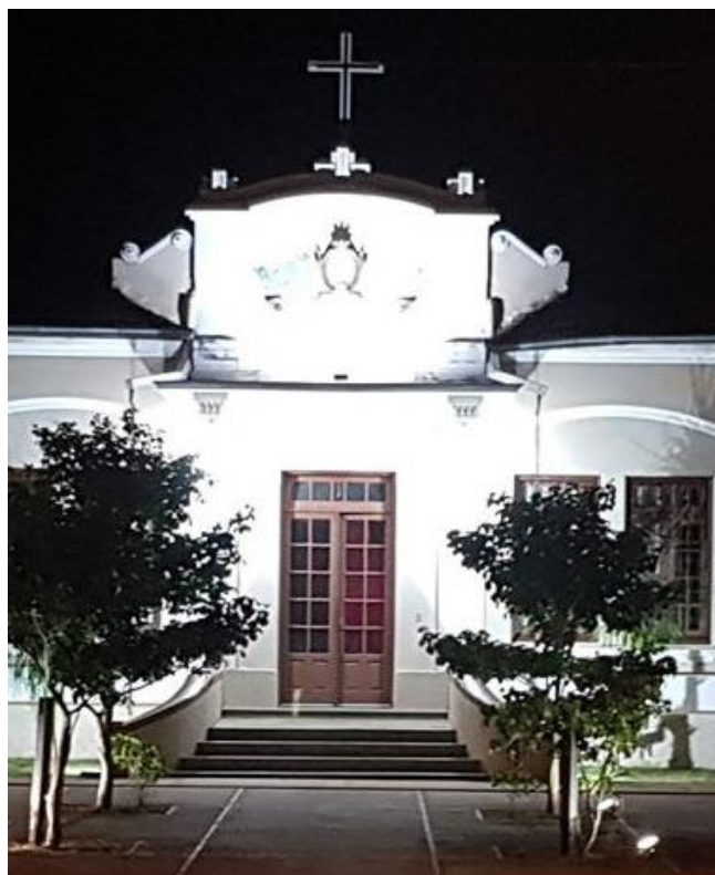
Figura 64 – Entrada do Colégio Santo Afonso.
