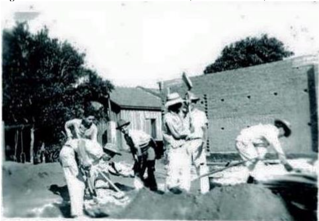
Figura 52 – Início das obras do Ginásio São José, na Rua Tiradentes, 1961.
