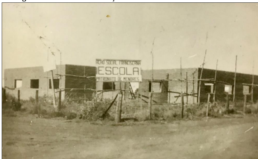
Figura 25: Prédio em construção do Patronato de Menores de Dourados
