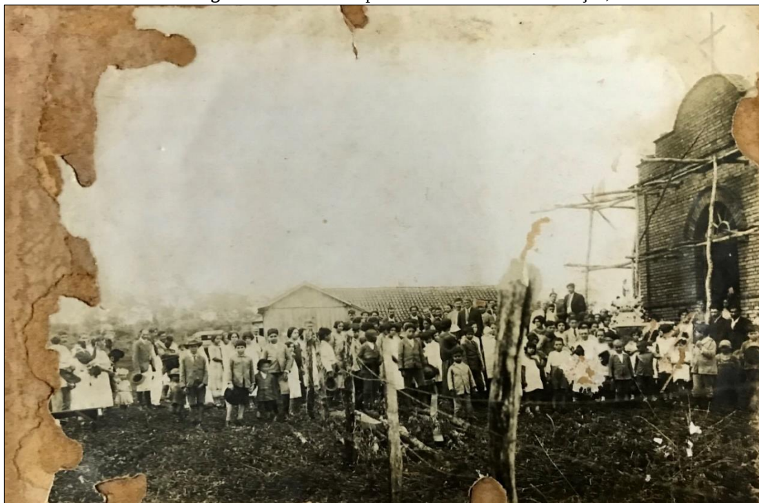
Figura 14: Primeira capela de Dourados em construção, 1925
