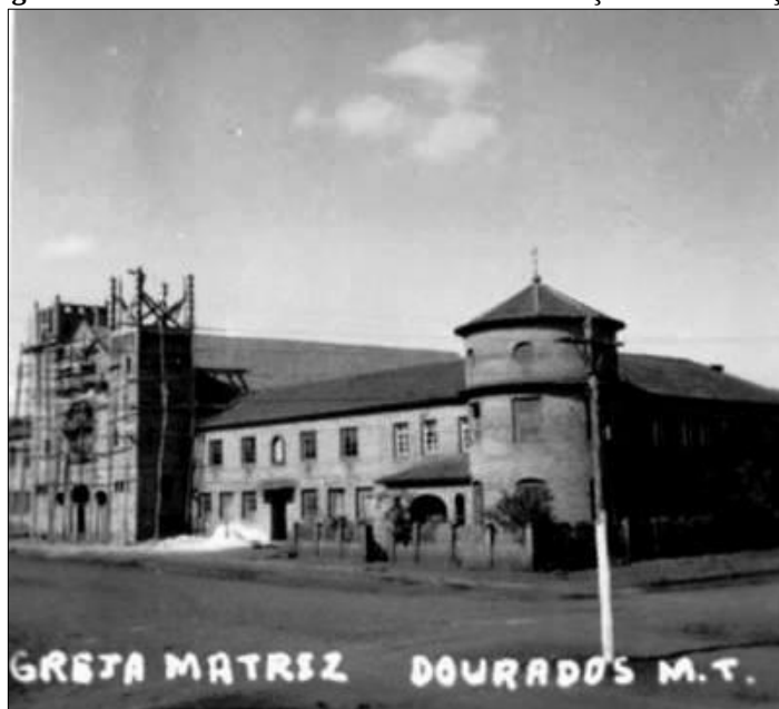
Figura 62: Fachada da Catedral Imaculada Conceição em construção
