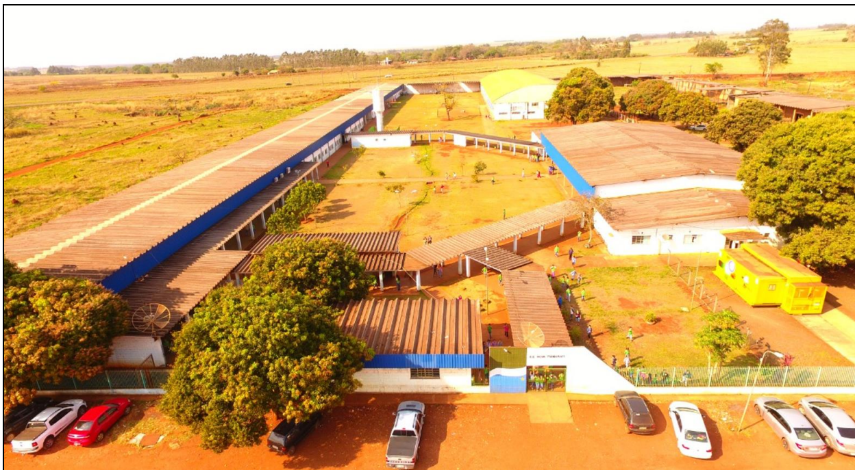
Foto 7 - Tomada aérea do complexo escolar
