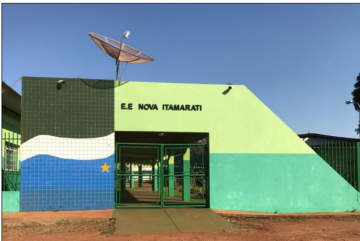
Foto 8 - Fachada atual da Escola Estadual Nova Itamarati
