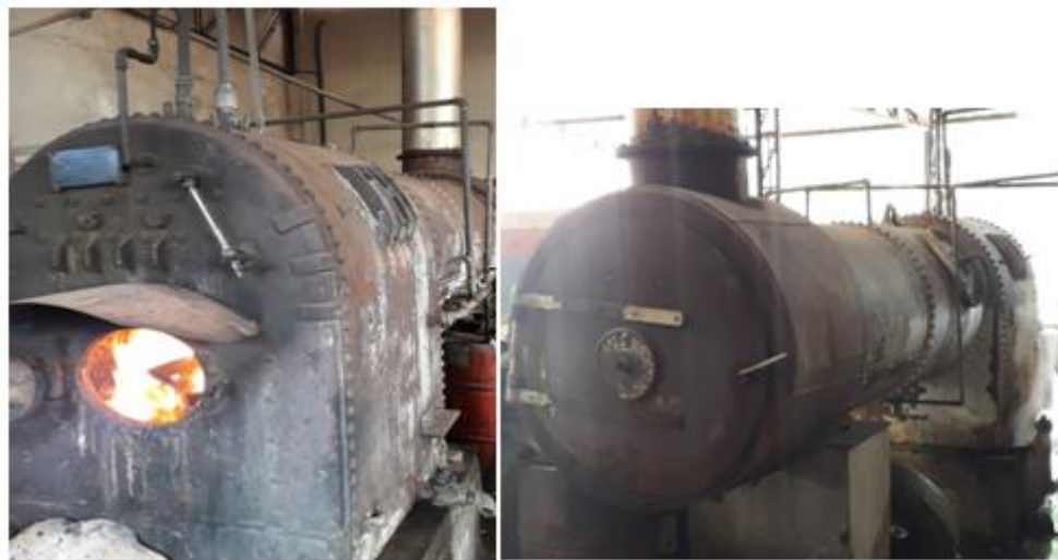
Figura 6.1 – Caldeira Flamotubular Horizontal Multitubular com fornalha externa.
