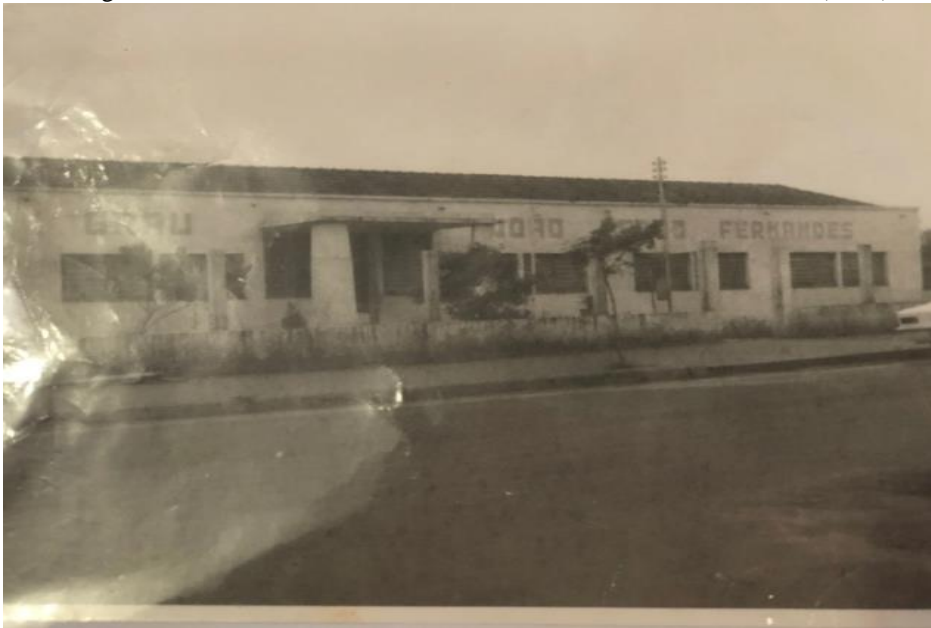
Fotografia 11 – Fachada da Escola Estadual de 1º Grau João Fernandes (1980)
