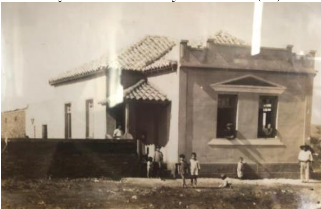
Fotografia 4 – Primeiro Prédio do Colégio João Pedro Fernandes (1930)
