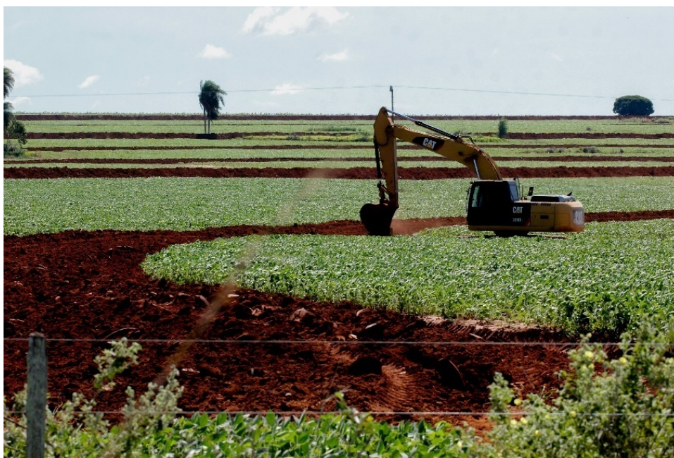
Foto 14 – Terraços sendo construídos em área de lavoura de soja as margens da MS 178 entre Bonito e Jardim MS
