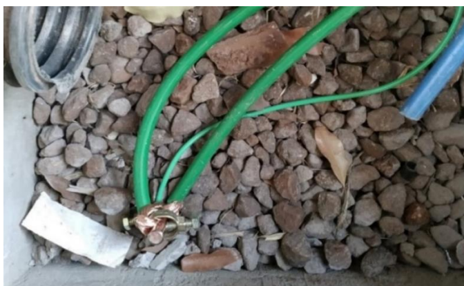
Figura 10. Barramento de equipotencialização.
