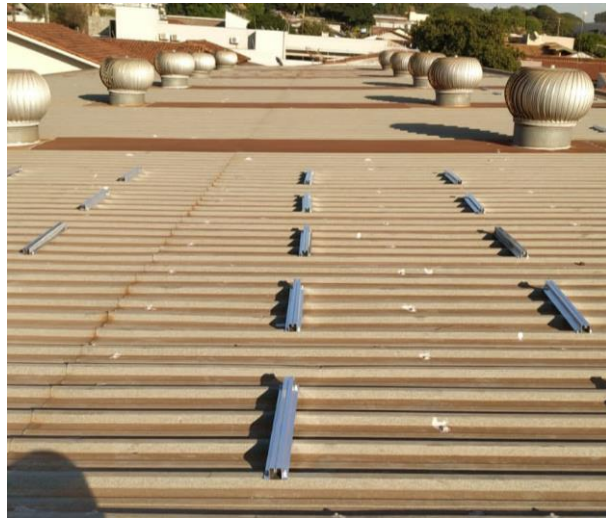
Figura 8.. Fixação dos módulos do SFV.
