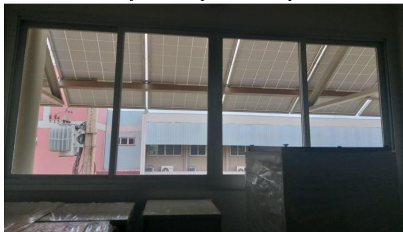
Figura 17 – Sombreamento nas janelas do pavimento superior ocasionado pelos brises.
