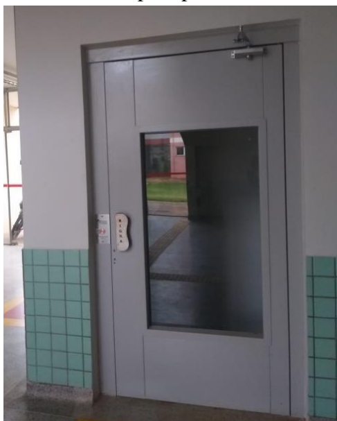
Figura 13 – Elevador para pessoas com deficiência.
