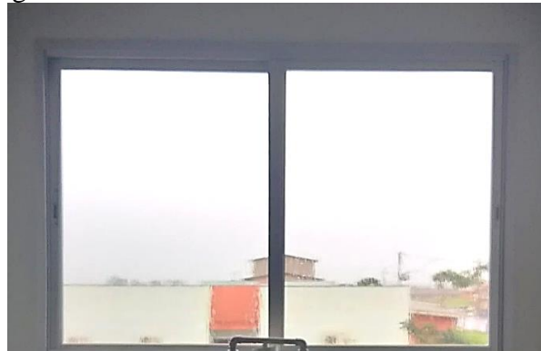
Figura 20 – Janela com abertura da fachada oeste.
