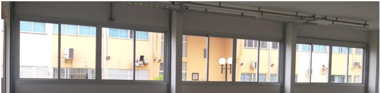
Figura 15 – Janelas das fachadas norte e sul.
