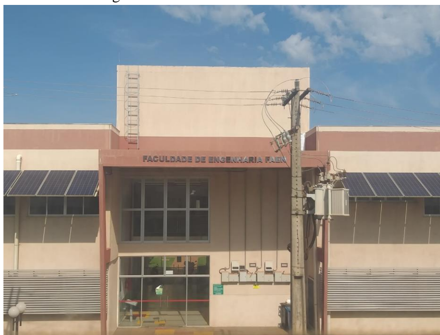
Figura 12 – Fachada do bloco da FAEN
