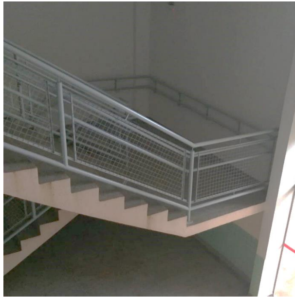
Figura 14 – Escadaria do bloco da FAEN.
