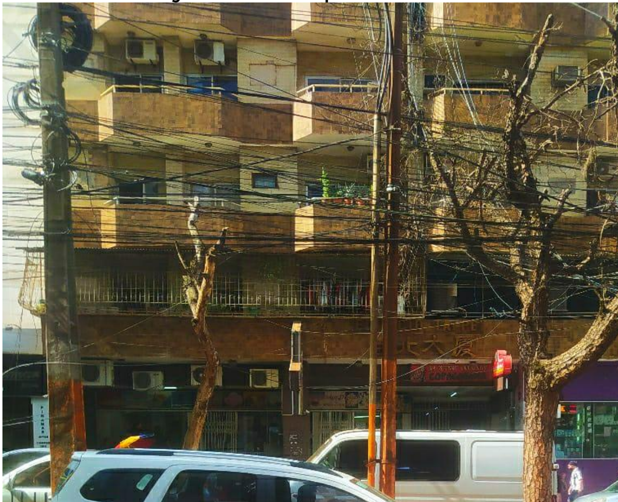
Fotografia 56 - Edifício Taipei em Ciudad del Este
