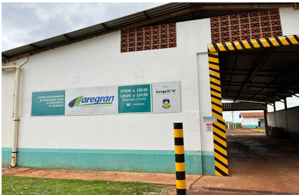
Figura 9 – Central de Recebimento em Dourados
