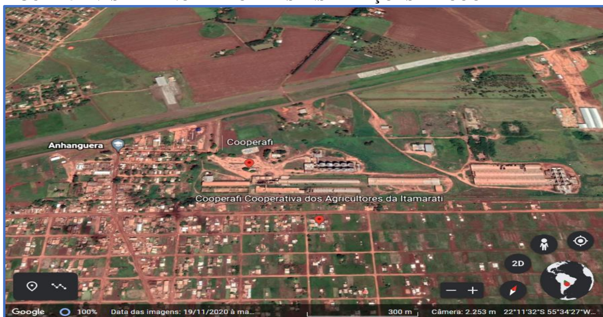
FIGURA 5 – VISTA PANORÂMICA DAS INSTALAÇÕES DA COOPERAFI
