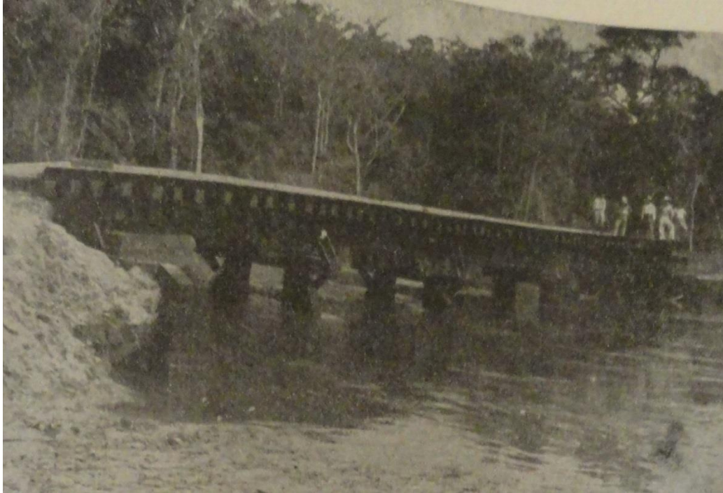
Figura 15: Ponte construída sobre o rio Tucabaca, na Bolívia
