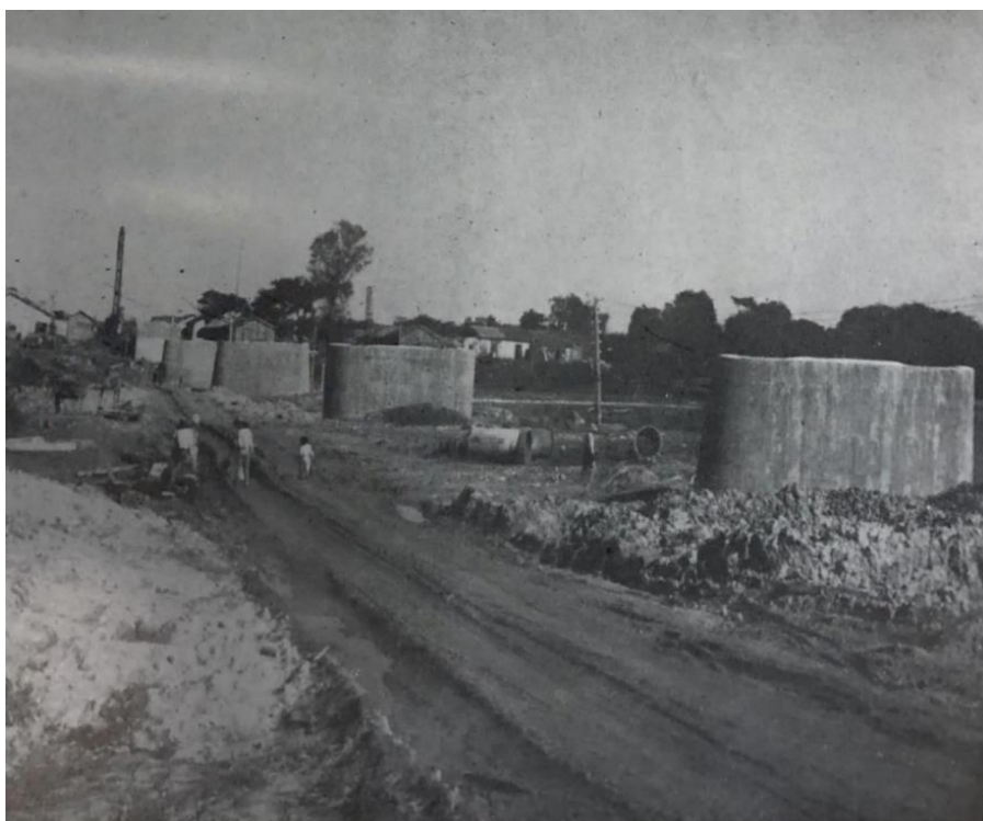
Figura 21: Os pilares da ponte sobre o rio Grande em Puerto Pailas, na Bolívia
