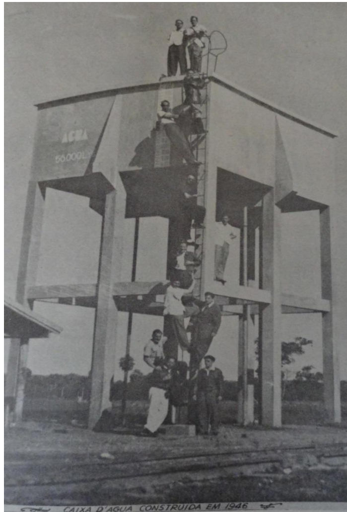
Figura 32: Modelo padrão de caixa d'água da Comista construída em 1946
