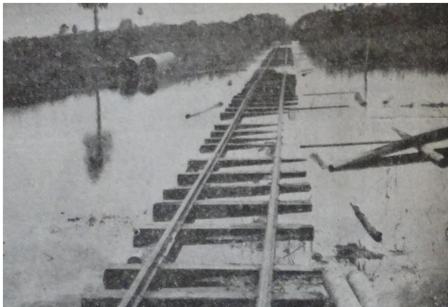
Figura 14: Trecho do Tacuaral inundado na fase de assentamento dos trilhos
