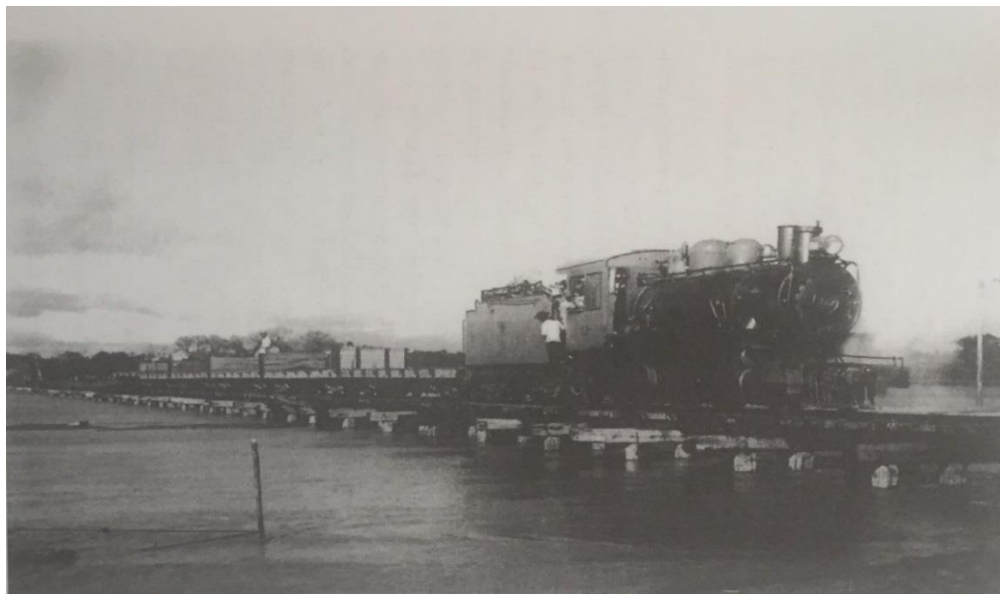
Figura 19: Ponte provisória de madeira sobre o rio Grande na Bolívia (cerca de 1953)
