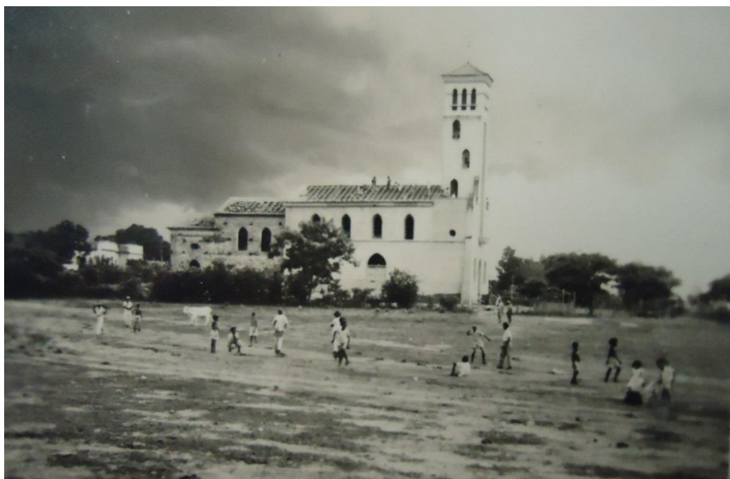
Figura 36: Prejuízos na igreja de Nossa Senhora dos Remédios em Ladário (1953)
