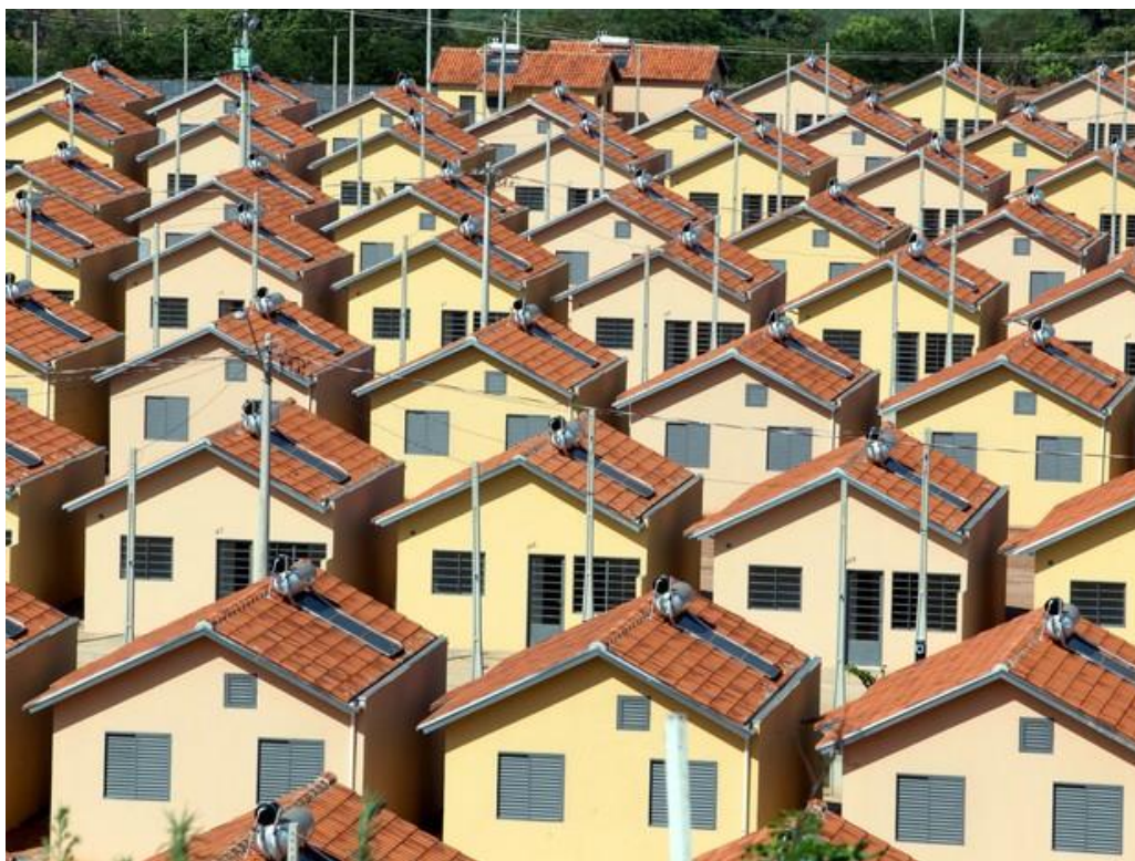
Imagem 4 – Conjunto habitacional Planalto Verde, São Carlos (SP).
