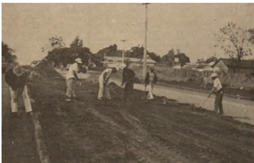
Figura 4 - Obras estruturais na rua Cuiabá, trecho referente à Feira Livre (julho de 1980)
