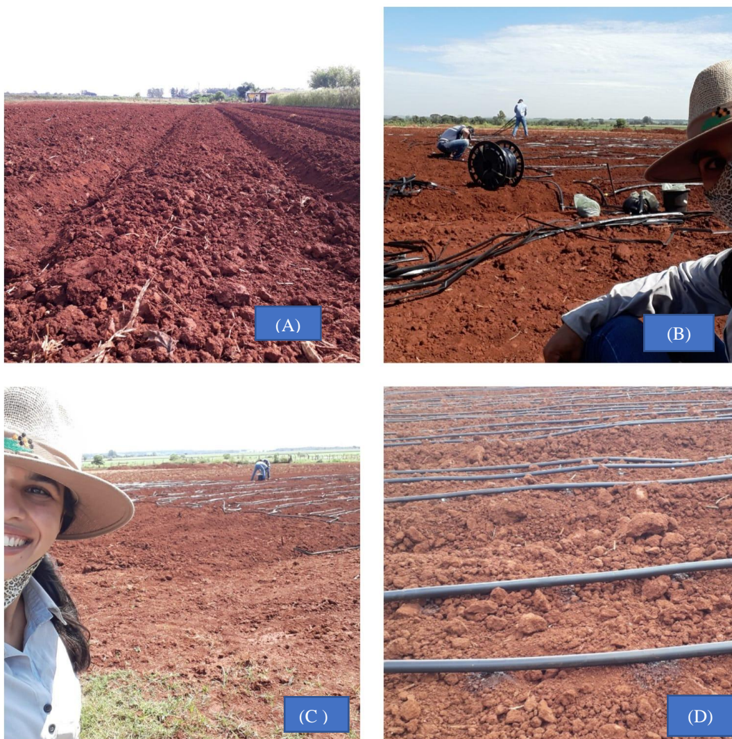
ANEXO 1. Área sendo preparada (A); mangueiras gotejadoras sendo instaladas (B); últimos ajustes para ligar as mangueiras gotejadoras(C); sistema de irrigação montado e funcionando corretamente(D). Dourados-MS, UFGD, 2021.
